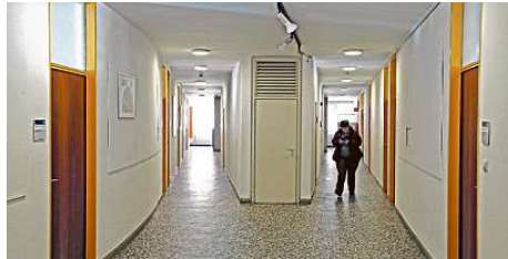
Originalzustand: Von den Fluren zweigen die Büros ab.
